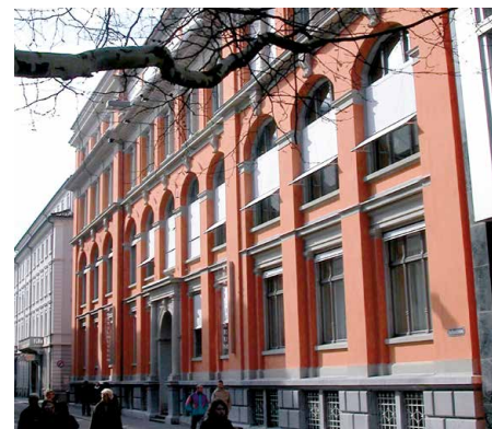
Die Fassade des Textilmuseums
