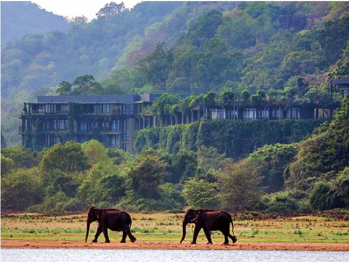
Einer der spektakulärsten Bauten Bawas: Das Hotel Kandalama
